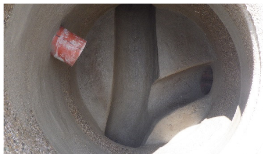
Schacht nach Sanierung
