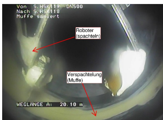
Verspachtelung der Schadstelle
